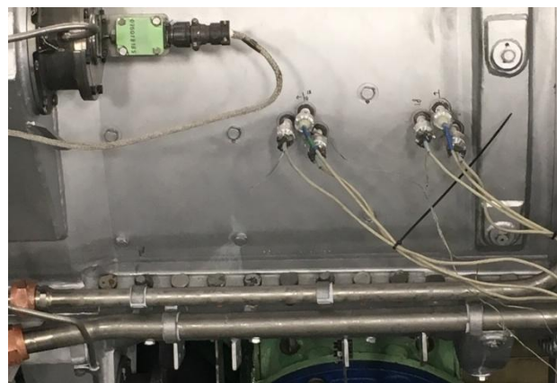
Рисунок 1. Датчики, установленные на 3-й и 4-й ступенях КНД ДН-80
