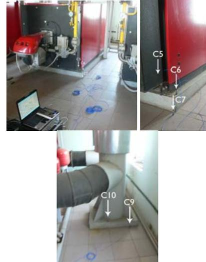
Рисунок 3 – Расположение датчиков вибрации
