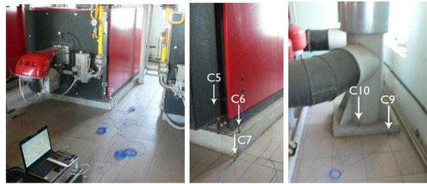
Рисунок 3 – Расположение датчиков вибрации
