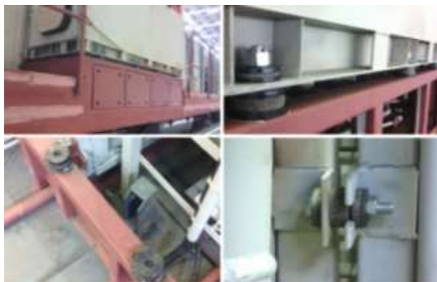
Рисунок 10. Монтаж системы виброзащиты кабины в процессе сборки тепловоза ТЭМ-28
